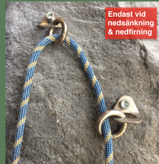
Bild 3: Repet ska endast träs genom stålringarna vid nedsänkning & nedfirning, ej vid klättring!
